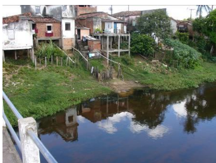
Foto 7.4 - As condições precárias atualmente existentes no quadro sanitário de Japomirim deverão ser melhoradas à medida que aumente a arrecadação municipal com o funcionamento da mina (23.06.2006).
