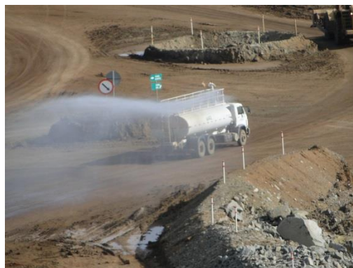
Figura 20 e 21 – Umidificação das vias de acesso com utilização de caminhão pipa.
