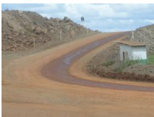
Figura 22 e 23 – Umidificação dos acessos da Mina com utilização de caminhão pipa.
