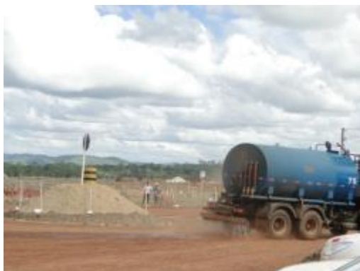
Figura 20 e 21 – Umidificação das vias de acesso com utilização de caminhão pipa.
