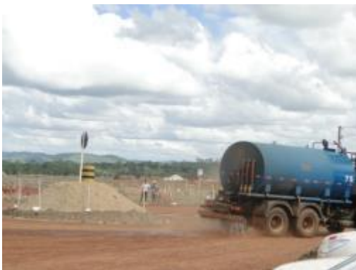
Figura 21 e 22 – Umidificação das vias de acesso com utilização de caminhão pipa.
