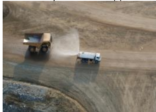
Figura 21 e 22 – Umidificação das vias de acesso com utilização de caminhão pipa.
