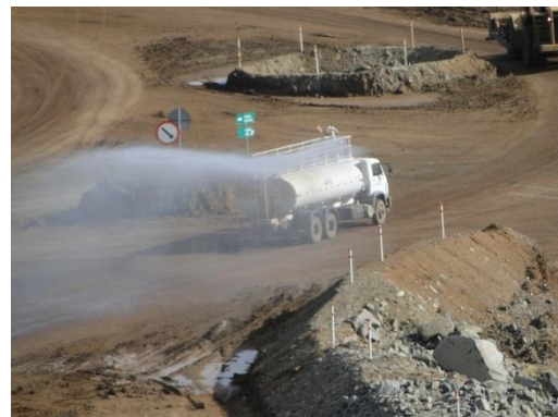
Figura 21 e 22 – Umidificação das vias de acesso com utilização de caminhão pipa.
