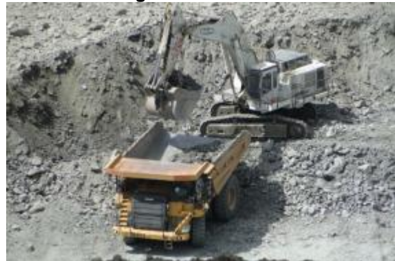
Figura 9 – Transporte de material
